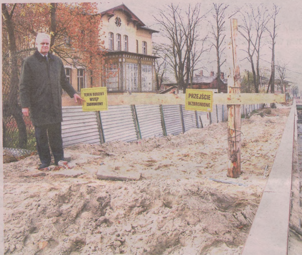
– Za ponad miesiąc piesi nie będą mogli tędy przejść, bo stanie tu ogrodzenie – mówi inżynier Adam Kalinowski.
