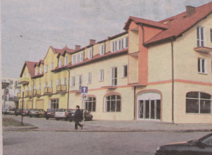
Termin otwarcia placówki zależy przede wszystkim od ekipy budowlanej, która pracuje wewnątrz budynku.
