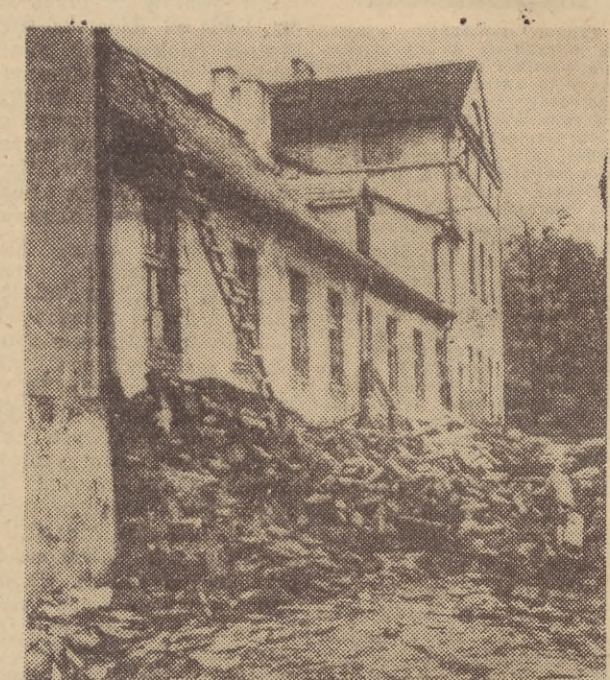
Oto „wizytówka” gdynskiego MPRB, wykonujący remont przy Al. Zwycięstwa 291 w Orłowie.
