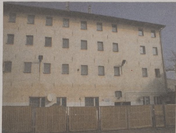
Budynek, w którym mieści się Dom Interwencji Kryzysowej PCK przy ul. Wolności 3
