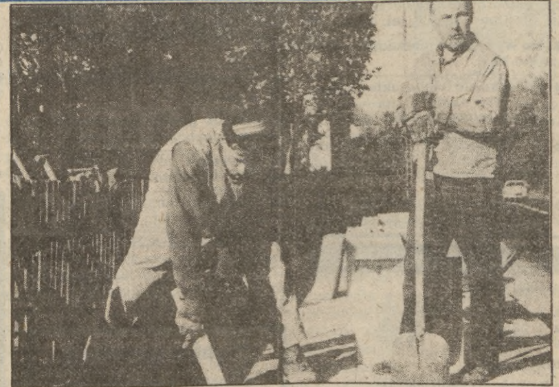
Mieszkańcy Głębina (nie opodal Słupska) już wkrótce otrzymają nowy chodnik ciągnący się wzdłuż wsi. Roboty te wykonują pracownicy ślupskiego przedsiębiorstwa dróg i mostów.
