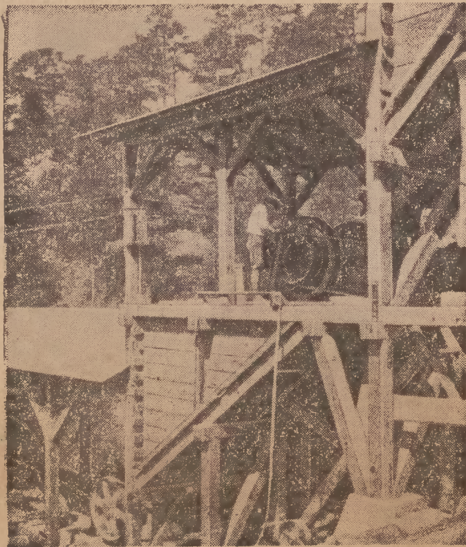
Die Gesteinsmühle, in der das goldhaltige Gestein zerkleinert wird.
