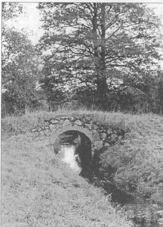
Mostek w Lubiewie
