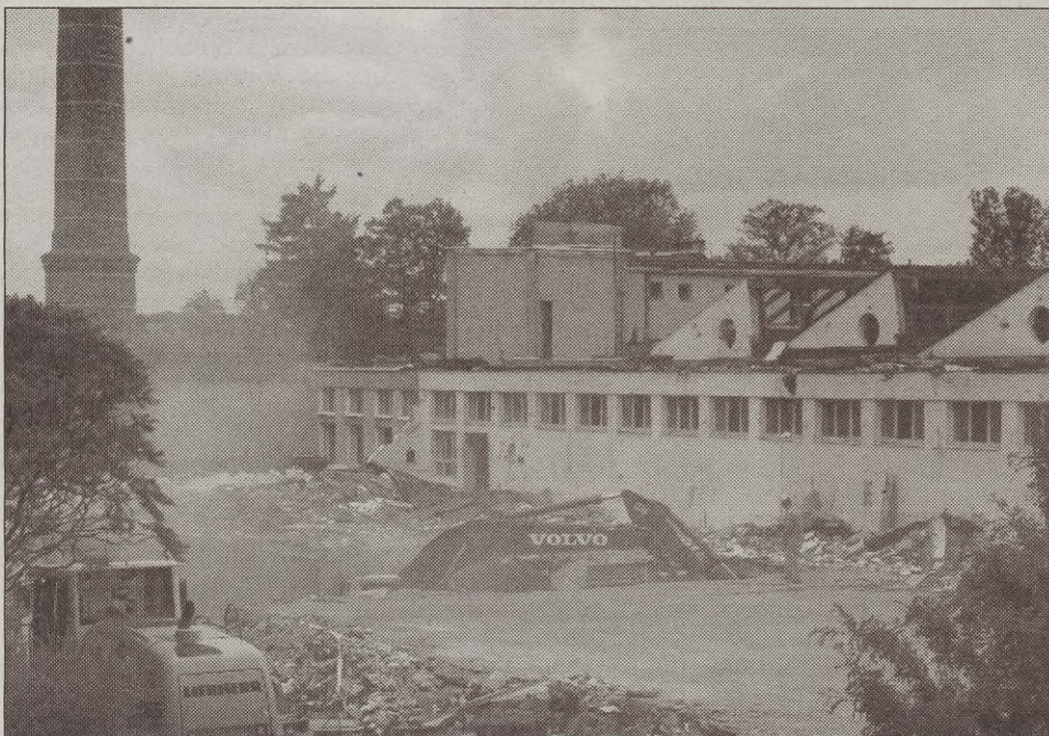
Trwa wyburzanie dawnych hal FRiOS-u. Za kilka miesięcy po fabryce nie będzie śladu. Teren zostanie podzielony na działki budowlane i sprzedany.
