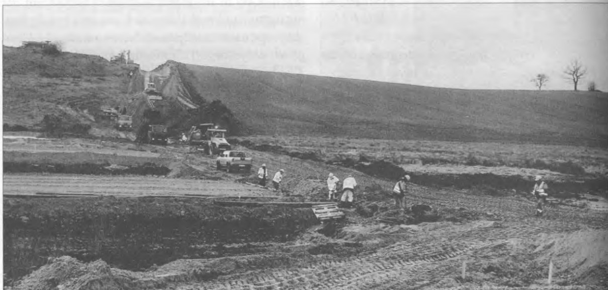
Zanim na plac budowy A-1 w pobliżu Ulków w powiecie gdańskim wjechały ciężkie maszyny, teren sprawdzili saperzy.
