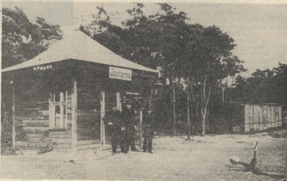
Pierwszy budynek „dworca”
