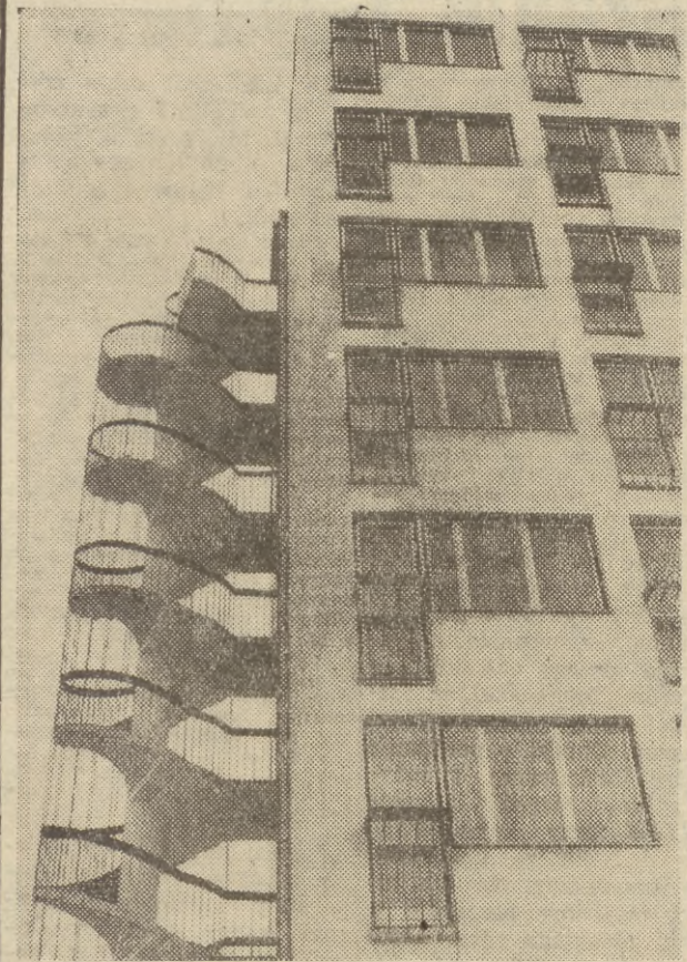
Dom mieszkalny na osiedlu Zatrasię przy ul. Broniewskiego 9 w Warszawie otrzymał klatkę schodową na zewnątrz budynku. Spieszmy wyjaśnić, że jest to tylko zejście awaryjne. Wewnątrz są normalne schody. W innym wypadku należałoby wspólnie mieszkańcom. CAF — Matuszewski
