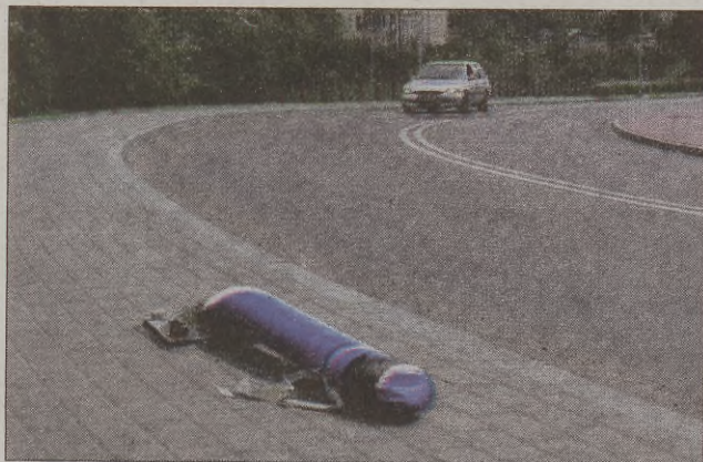
Przewód na chodniku przy ulicy Kaszubskiej w Miastku. Zniknie przed świętami, bo w tym miejscu będzie nowa lampa.
