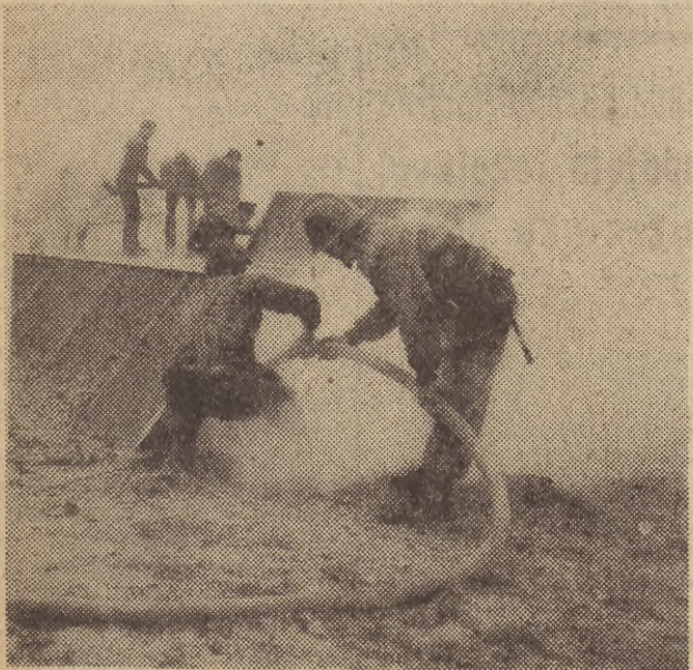
Strażacy i członkowie załogi gaszą ogień na dachu pionącej hali fabrycznej.
