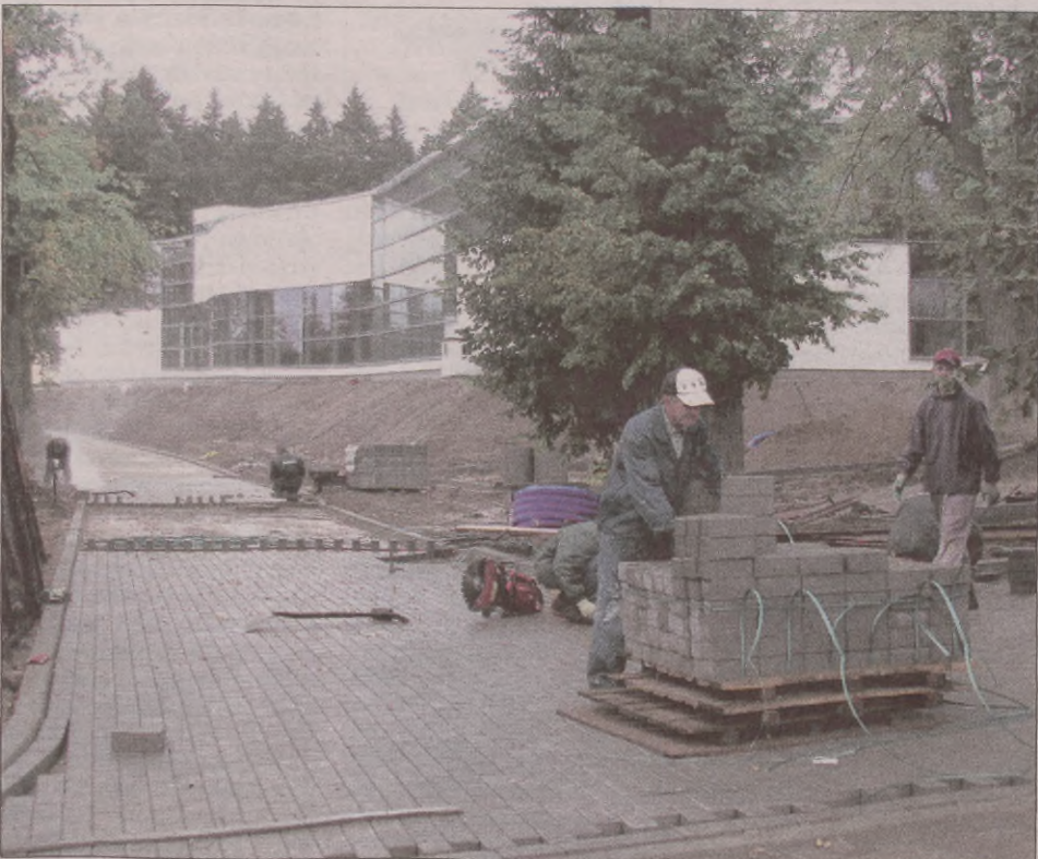
W tym roku jest mało gminnych inwestycji w gminie Miastko. Z dróg to przebudowa ulicy Sadowej i Wiśniowej.
