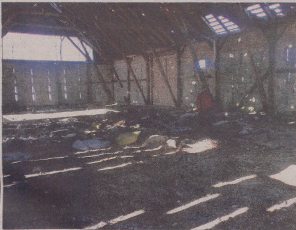
Zrzuwany budynek między Cewicami a Łebunią.
