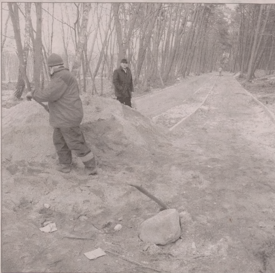
Rozpoczęły się prace, mające na celu przebudowę stawku.
