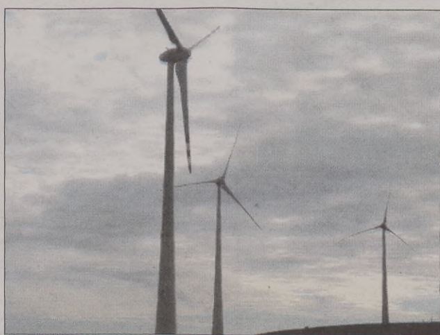
W Wicku stoi już pięć wiatraków.
