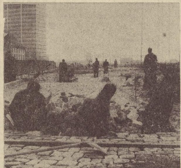
Bruckarze układają dolną warstwę jezdnii (z kamienią), którą pokryją dwiema warstwami asfaltu. Fot. Wł. Nieżywiński
