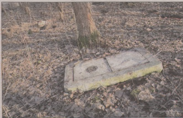
Po naszej interwencji na studzienkę wróciła pokrywka.
