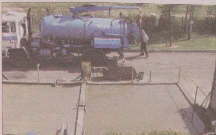
Oczyszczalnia w Przyborzycach zostanie zmodernizowana.
