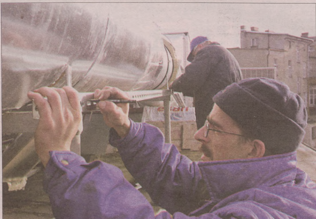
Ryszard Siciński kończy montaż klimatyzacji w Rondzie. Efekt jego pracy będzie można odczuć już za kilkanaście dni.
