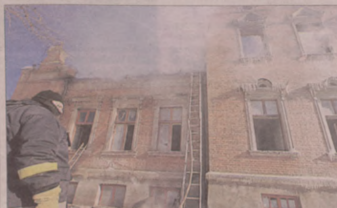
Ogień niemal doszczętnie strawił budynek domu opieki.
