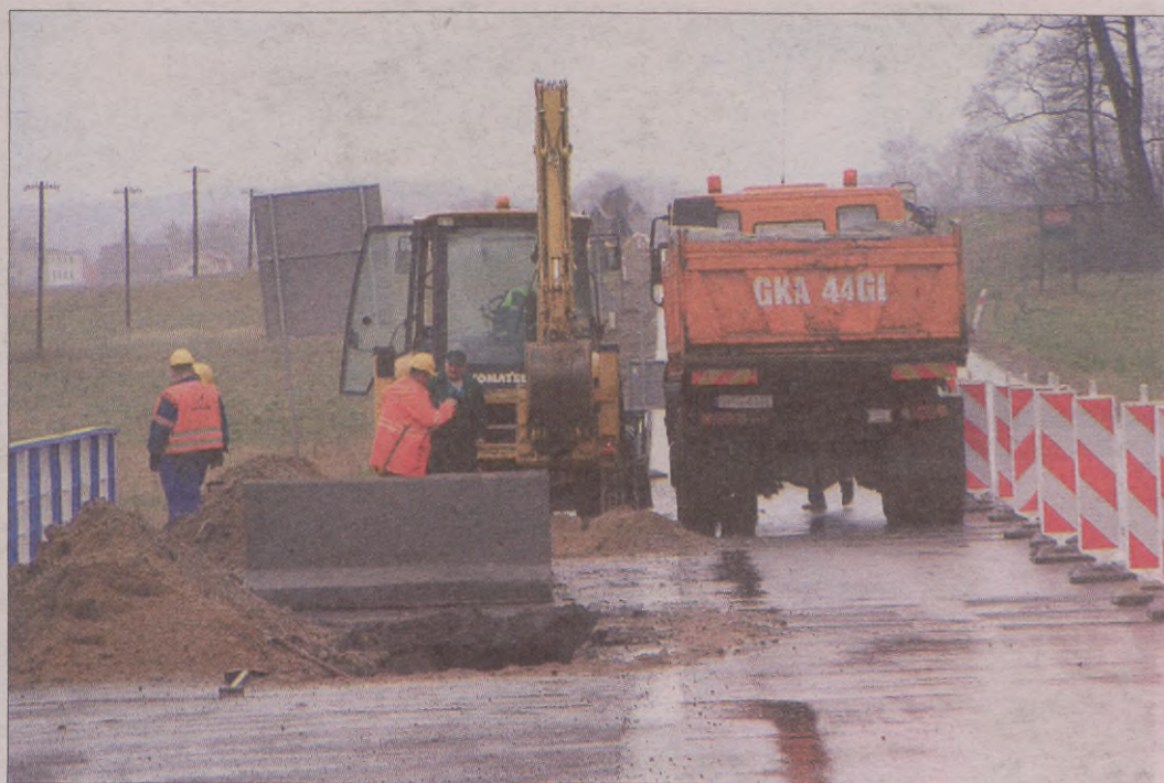
Dyrekcja GDDKiA w Gdańsku zapewnia, że remont drogi krajowej numer 6 zakończy się w terminie, czyli do 30 czerwca.
