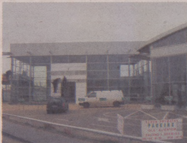
Na zdjęciu: Budowany w Szczecinie salon Volkswagena; imponująca konstrukcja ze szkła i stali, wysokość 9 metrów, szerokość 30 metrów.
