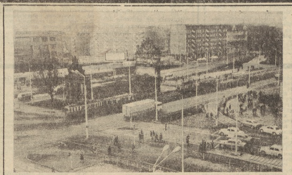
Przez wiele lat węzeł komunikacyjny przy Bramie Portowej w Szczecinie nosił niechlubne miano Bramy Korkowej. Nazwa ta przylgnęła z uwagi na ciągłe zatory i utrudnienia, jakie napotykała komunikacja miejska w tym miejscu. Ostatnio zakończono tu przebudowę układu komunikacyjnego i dzięki temu jest to najnowocześniejsze rozwiązanie w Szczecinie. Zastosowano sygnalizację i ruch trójfazowy, przebudowano przedmiotem odpowiednio poszczególne ulice zbiegające się przy Bramie Portowej. Na zdjęciu: węzeł komunikacyjny przy Bramie Portowej. CAF — Witusz
