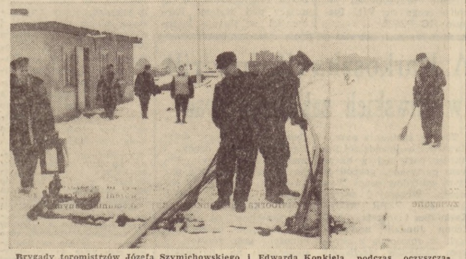
Brigady torowisk Józefa Szymichowskiego i Edwarda Konkla podczas oczyszczania rozjazdów na stacji Gdańsk-Południe. Fot. Wł. Nieżywiński
