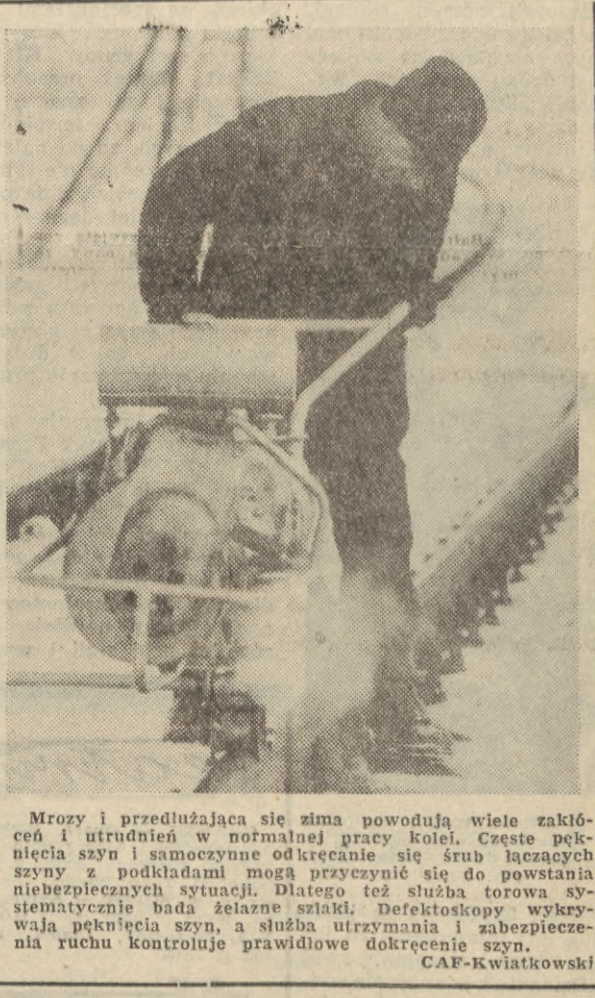
Mrozy i przedłużająca się zima powodują wiele zakłó- ceń i utrudnień w normalnej pracy kolei. Często pe- knięcia szyn i samoczynne odkręcanie się szrub łączących szyny z podkładkami mogą przyczynić się do powstania niebezpiecznych sytuacji. Dlatego też służba torowa sy- stematycznie bada żelazne szlaki. Defektoskopy wykry- wały peknienia szyn, a służba utrzymania i zabezpiecze- nia ruchu kontroluje prawidłowe dokręcenie szyn. CAF-Kwiatkowski
