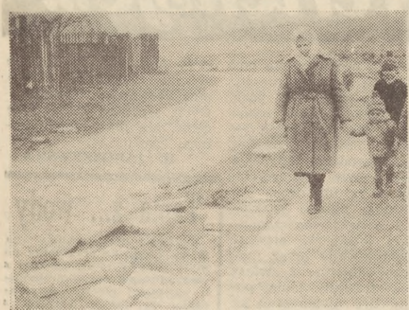
Fragment ulicy Na Zboczu — straty z powodu zniszczenia chodnika na odcinku około 120 m oblicza się na blisko 8 tys. zł.
