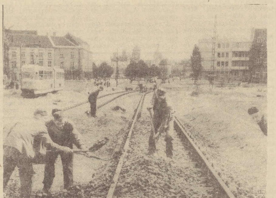
Na zdjęciu: żołnierze przy plantowaniu tuczni na nowych torach ul. Hucisko w Gdańsku. Za parę miesięcy widoczny na zdjęciu tramwaj będzie kursować właśnie po tych torach, a obecną linię tramwajową na tym odcinku zlikwiduje się.
