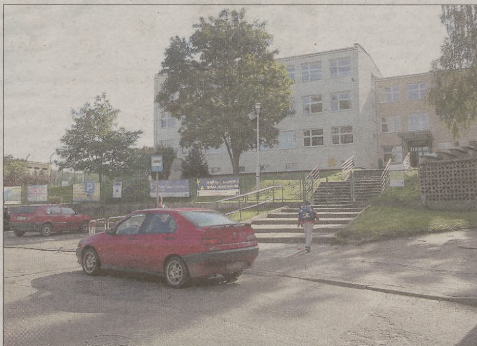
W Bytowie planowana jest przebudowa ulicy Młyńskiej.
