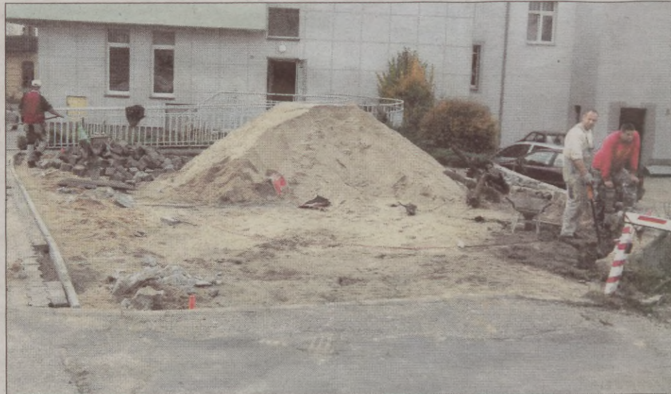
Prace przy ulicy Młyńskiej w Bytowie właśnie rozpoczęto.
