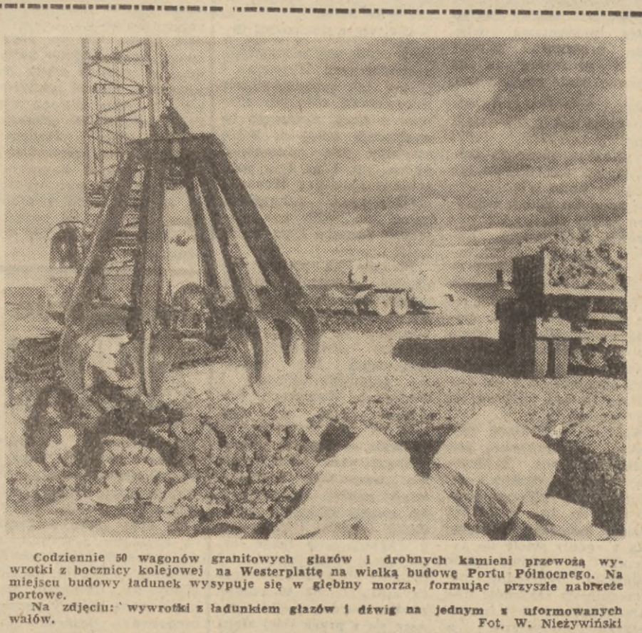
Co dziennie 50 wagonów granitowych głazów i drobnych kamieni przewożą wywrotki z hucniej kolejowej na Westerplatte na wielką budowę Portu Północnego. Na portowej. Na zdjęciu: wywrotki z ładunkiem głazów i żwiru na jednym z uformowanych Fot. W. Nieżyński
