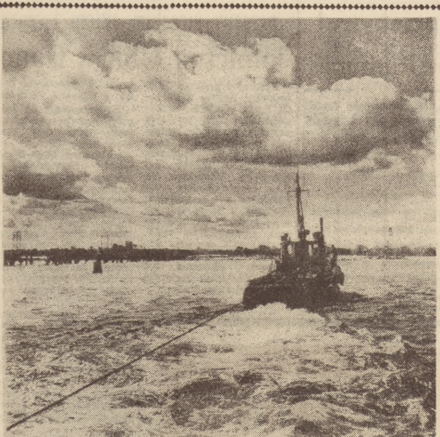
Trwa budowa Portu Północnego w Gdańsku. Każdego dnia, od świtu do nocy, bezustannie pracują holowniki dostarczające na budowę niezbędne materiały. Na zdjęciu: fragment Portu Północnego w Gdańsku — ten holownik rozpoczął pracę wczoraj rano, kiedy niebo było gęsto pokryte chmurami dopiero się rozjaśniało. Fot. M. Zarzecki
