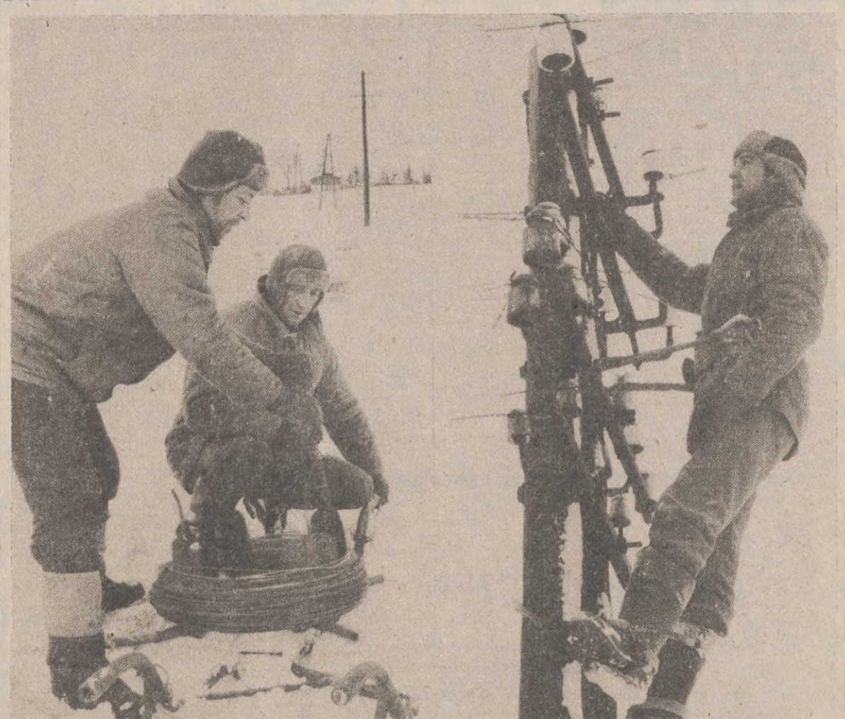
Coraz szerzej wkracza automatyzacja telefoniczna do gmin. Po zamontowaniu nowej centrali telefonicznej w Dygowie i ułożeniu kabla podziemnego z Kołobrzegu do Dygowa, przystąpiono do likwidacji jeszcze do niedawna działającej linii napowietrznej. (kar)
