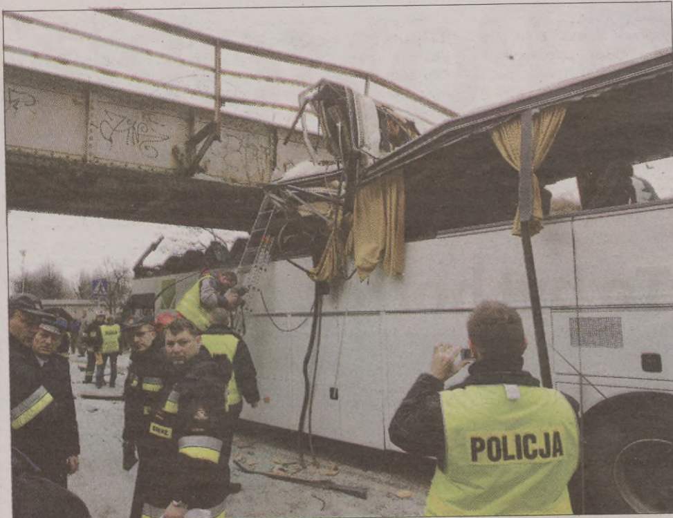
Wiadukt kolejowy w centrum Świdnicy ma 2,9 m. Wysokość autokaru to 3,75 m.
