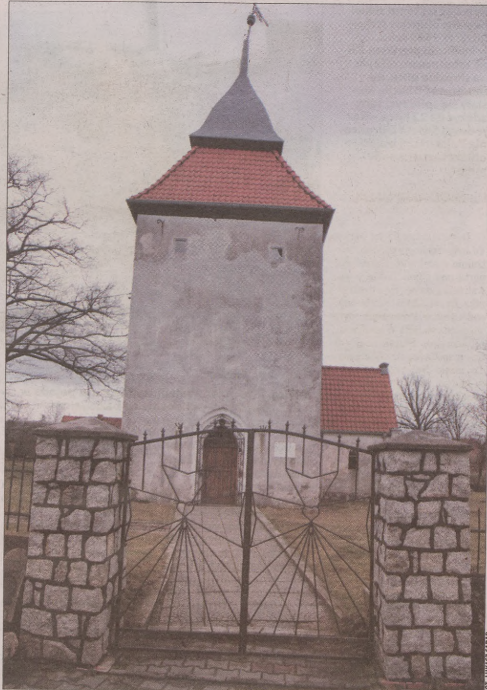
Kościółek w Swołowie. Piękny, ale niszczący. Ma szansę na renowację.
