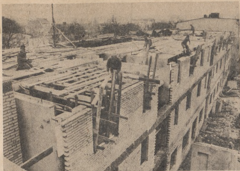
Coraz wyżej wznoszą się nowo budowane domy w rejonie kołobrzeskiego Starego Miasta. Jeszcze w tym roku wprowadzą się do nich pierwsi lokatorzy.
