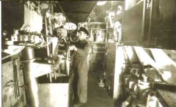
Prace wyposażeniowe w maszynowni Soldka .
