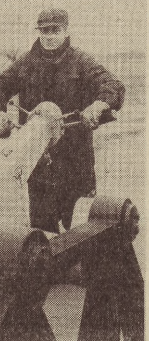
Na zdjęciu: Ubiórzenie ziemi pod budowę. Sprawnie wykonuje to pracownik GPRB Zbigniew Wasilkowski przy pomocy zagęszczarki WZK-10. Fot.: Z.K.
