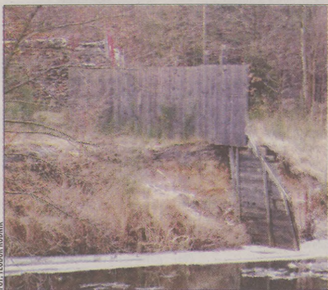
Ogrodzenie uniemożliwiające wędkarzom przejście nad rzeką Słupią.
