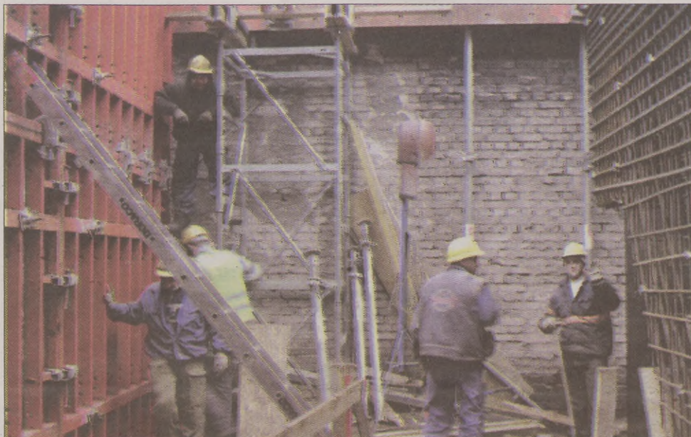
Budowa Galerii Słupsk. Część zatrudnionych tu robotników to obcokrajowcy.
