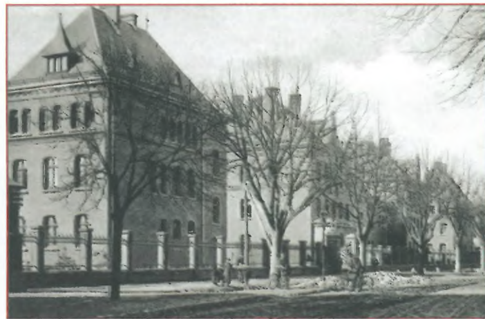
Foto str. 82-83: Widoczne na fotografii budynki wzniesiono w latach 1893-1896, a przeznaczone były na siedzibę sztabu pułku, na mieszkania podoficerów i ich rodzin oraz (środkowy budynek) dla żołnierzy dwóch szwadronów 1. pułku.
