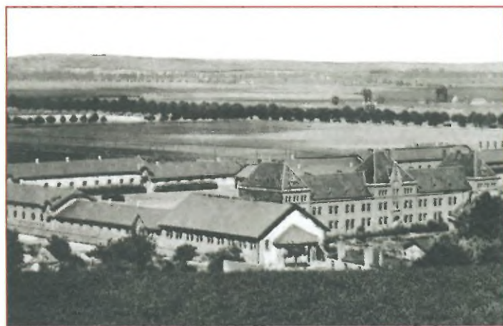
Foto str. 78-79: Przywołany w podpisie (str. 77) barak z charakterystyczną przybudówką to solidny, ceglany budynek ujeżdżalni 2. pułku huzarów, o powierzchni ponad 1600 metrów kw! Pochodzi z lat 1900-1901.
