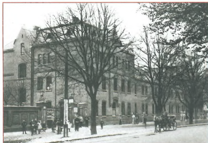
Foto str. 79, fotografia dolna: Budynek na niej widoczny był budynkiem przeznaczonym dla dwóch kompanii 17. batalionu taborów. Pochodzi z lat 1890-1893.
