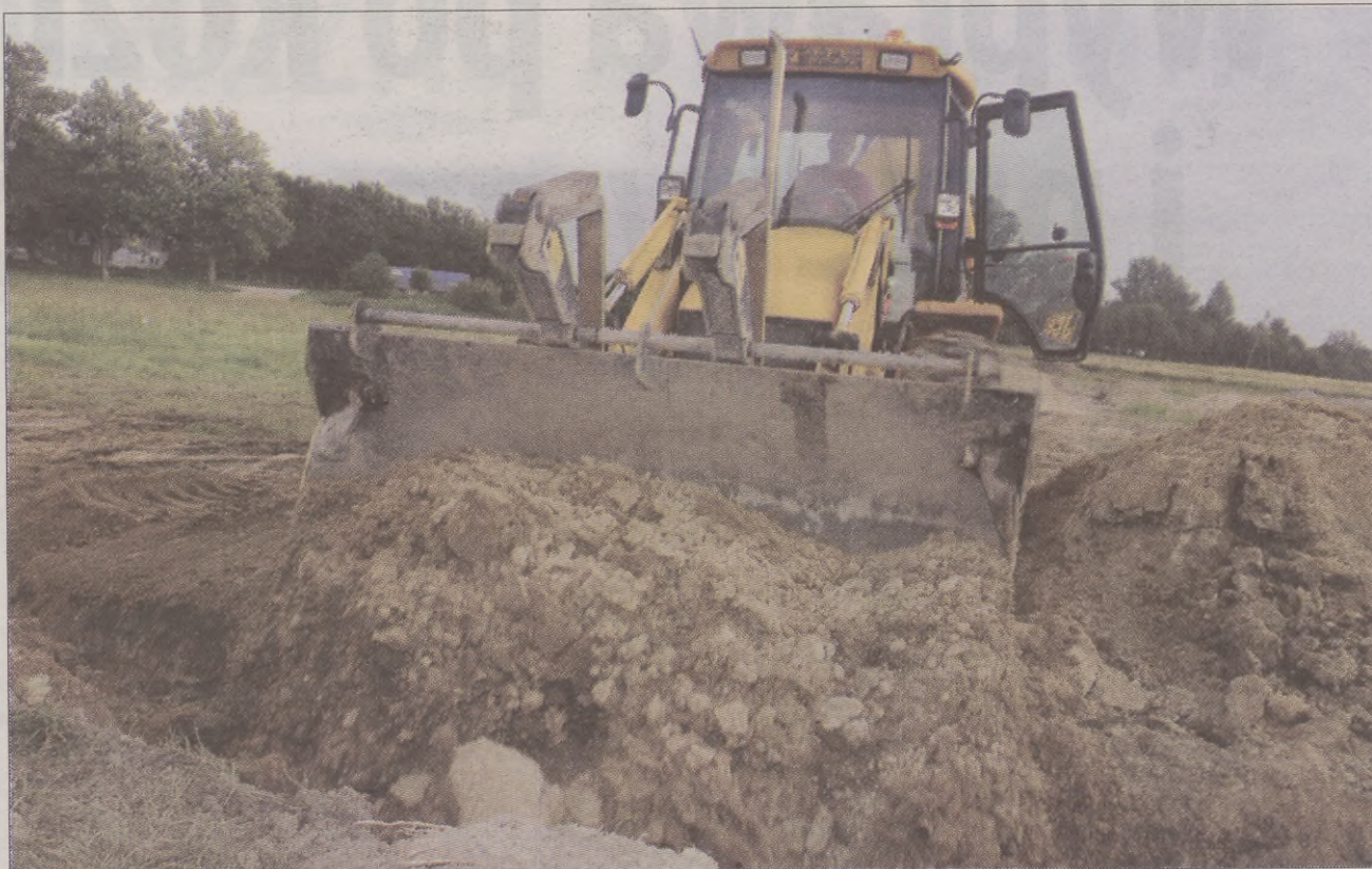
W Kwakowie już trwają prace ziemne na terenie, gdzie zostanie ułożona sztuczna murawa.
