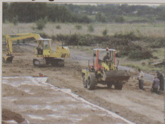
Budowa boisk w Przechlewie.
