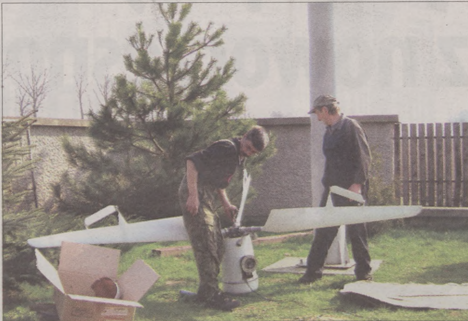
Montaż przydomowej elektrowni wiatrowej.
