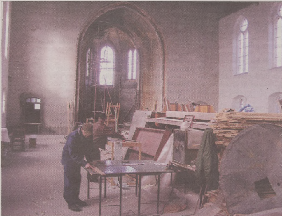
Mieszkańcy Tuchomia podczas prac remontowych w kościele.
