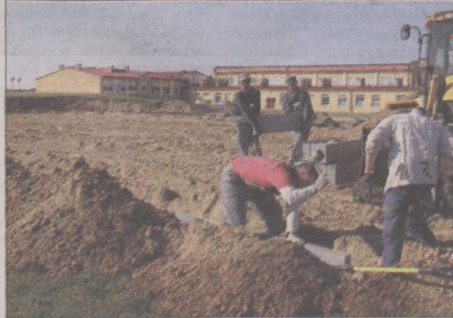
(ANG) Budowa Orlika w Bydgoszczy.
