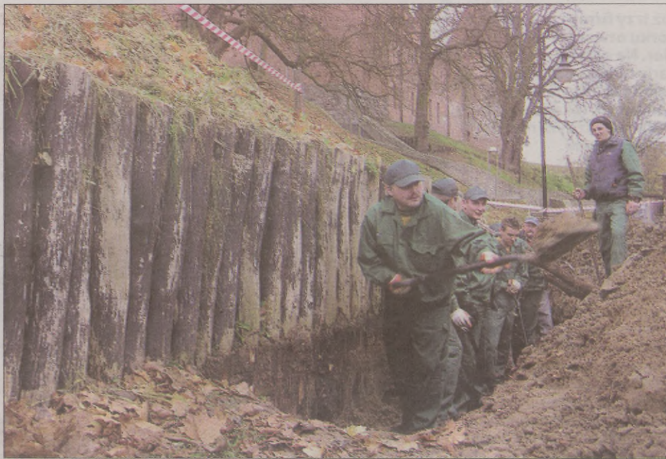
Prace przy rozbiórce drewnianej palisady.
