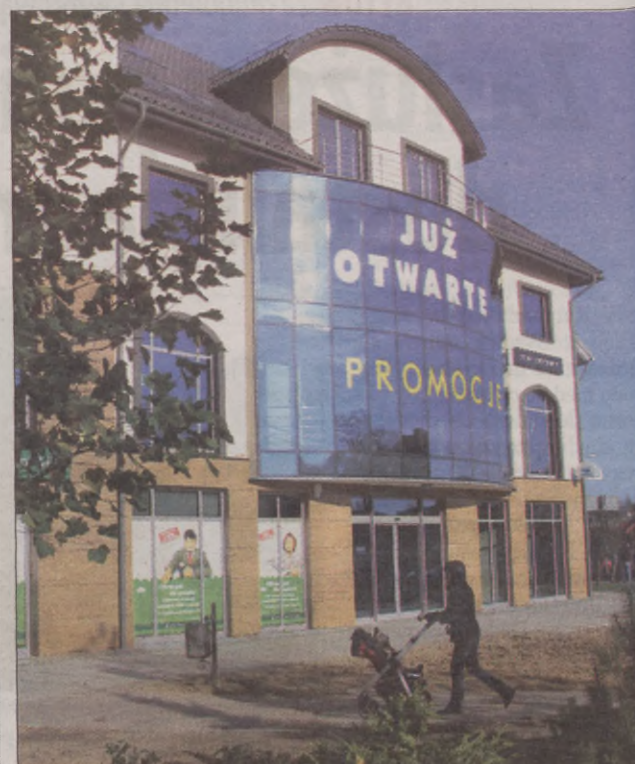
Centrum przy ul. Staromiejskiej.
