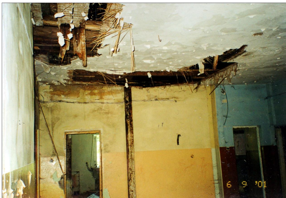
Ryc. 16. Pałac w Poganicach – przed remontem Źródło: Sławomir Żabicki (2001)
