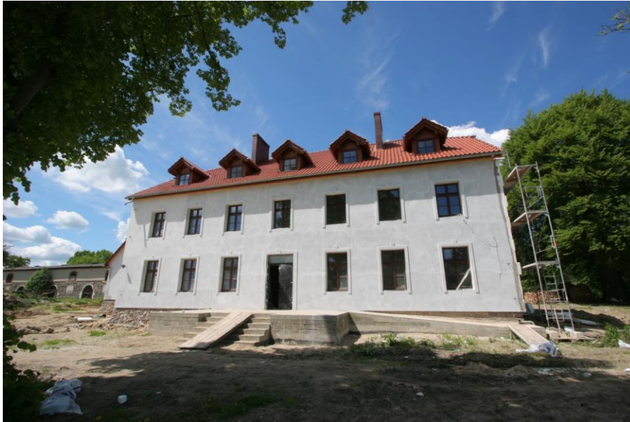
Ryc. 9. Pałac Płocko –w trakcie remontu Źródło: Sławomir Żabicki (2006)
