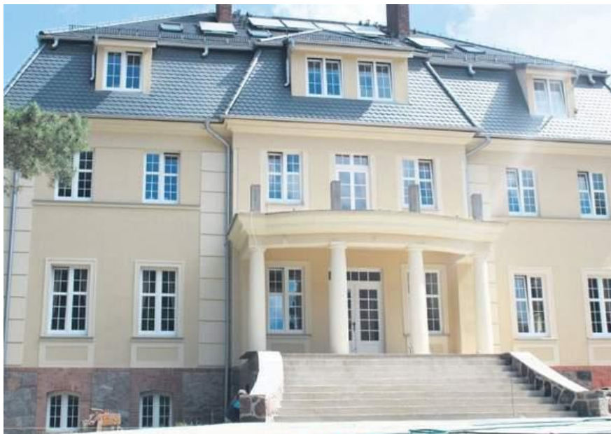
Ryc. 21. Pałac w Ściegnicy – po remoncie Źródło: www.gp24.pl (2013)
