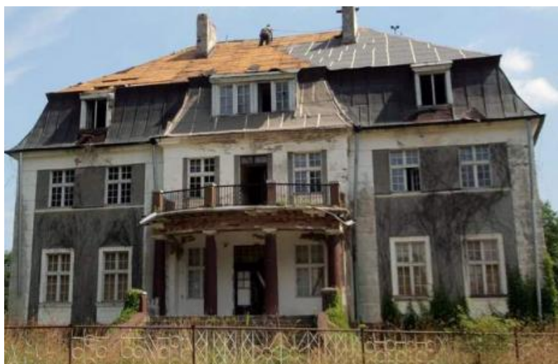
Ryc. 20. Pałac w Ściegnicy – przed remontem Źródło: Sławomir Żabicki (2009)
