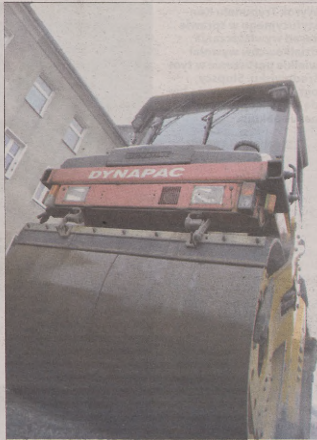
Walec na remontowanej ulicy Paderewskiego.
