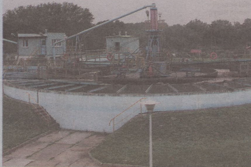
„Stara oczyszczalnia ścieków w Goleniowie już niebawem będzie spełniać najbardziej surowe unijne wymogi”
