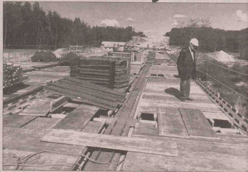
Budowa mostu drogowego obwodnicy na rzece Słupi.
