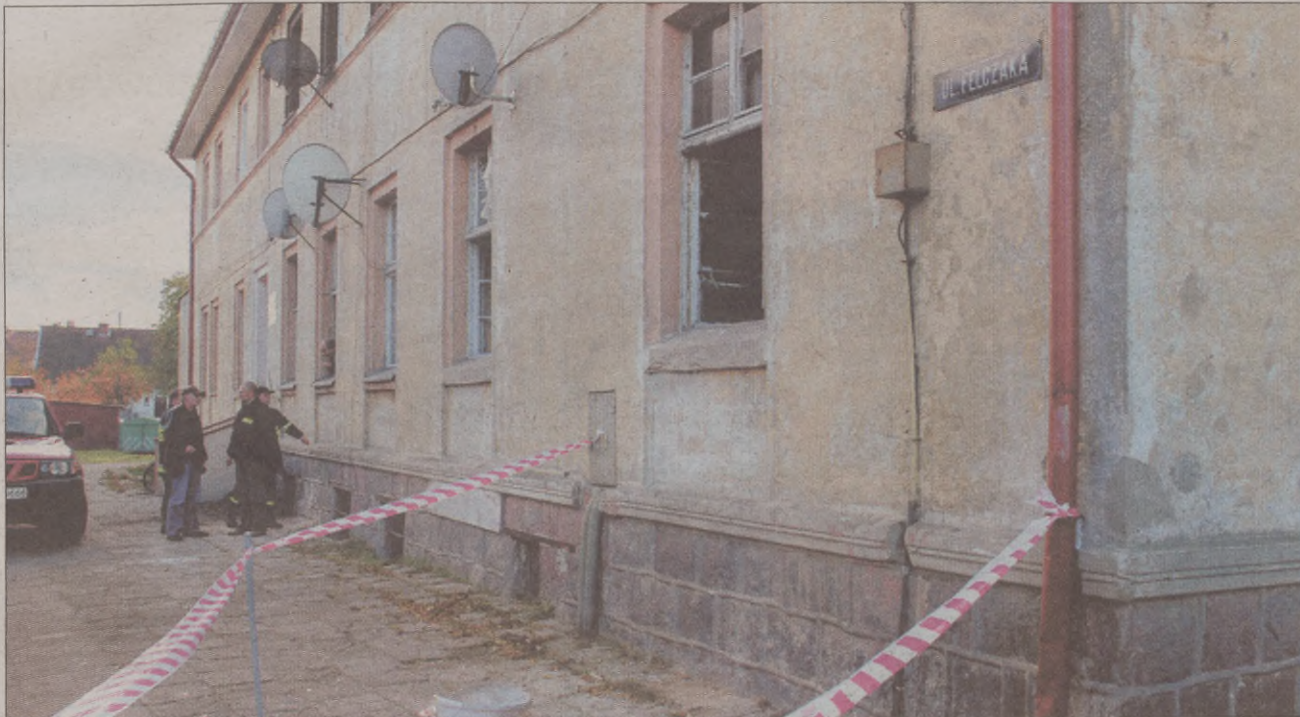
Kamienica przy ul. Felczaka w Człuchowie po pożarze mieszkania na parterze.
