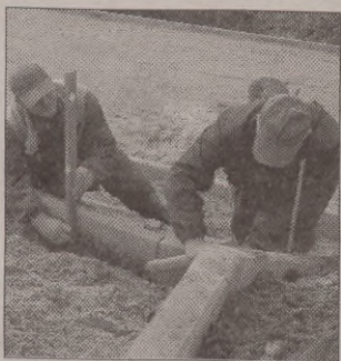
Prace przy budowie boisk przy ulicy Mierosławskiego.
