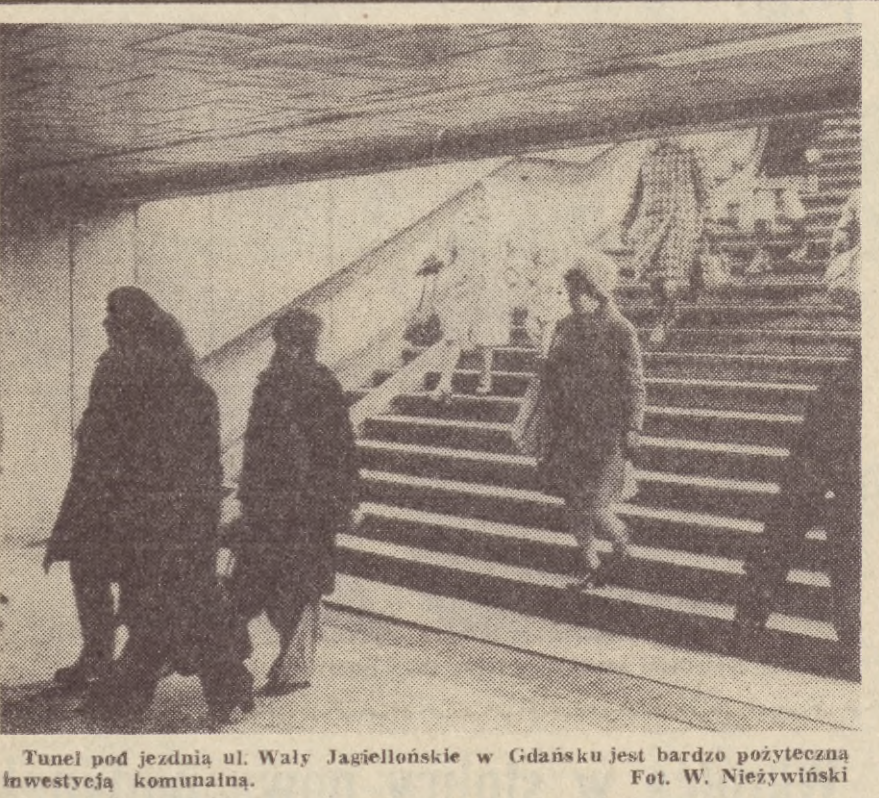
Tunel pod jezdnią ul. Właj Jagiellońskiej w Gdańsku jest bardzo pożyteczną inwestycją komunalną. Fot. W. Nieżywiński
