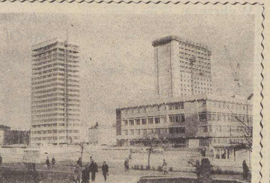
Dwa wieżowce w budowie (od lewej) dla Biura Projektowo - Technologicznego MSR „Prorem” i hotel „Hewelusz” dla „Orbisu”. Fot. W. Niekłowski
