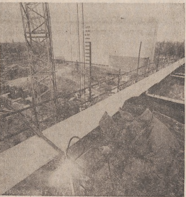
Prace przy budunku zbiorów Biblioteki.
