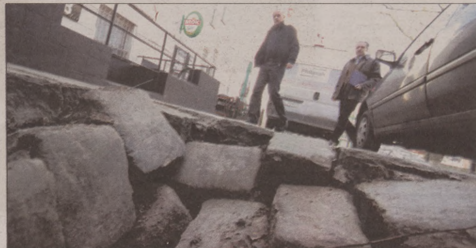
Zapadnięta kostka brukowa przy ul. Anny Łaming.
