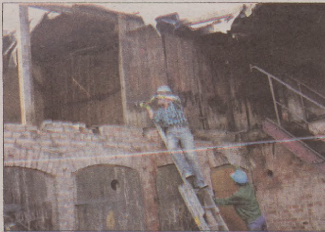
Demontaż drewnianego piętra na podwórku przy ulicy Małachowskiego 32 w Słupsku.
