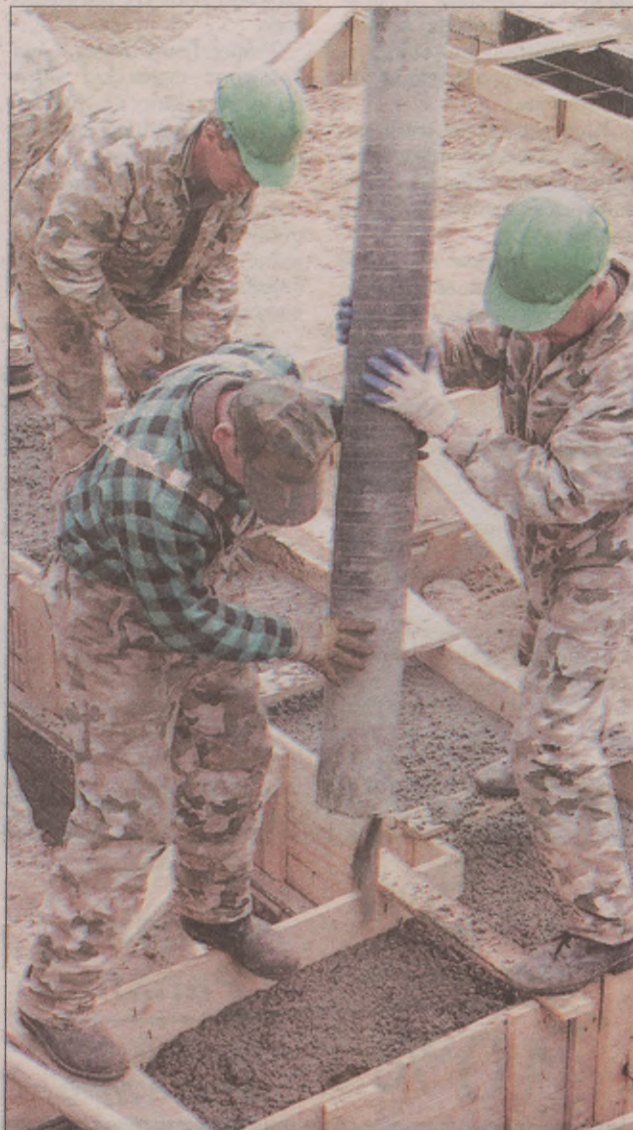
Wylewanie mieszanki betonowej w deskowaniu fundamentów wykonuje się jednocześnie z zagęszczeniem, które ma na celu dokładne wypełnienie formy, szczególnie między gęsto rozstawionymi prętami zbrojenia oraz w załamaniach form.
